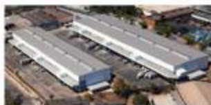
Log Contagem II 14.000 m 2
